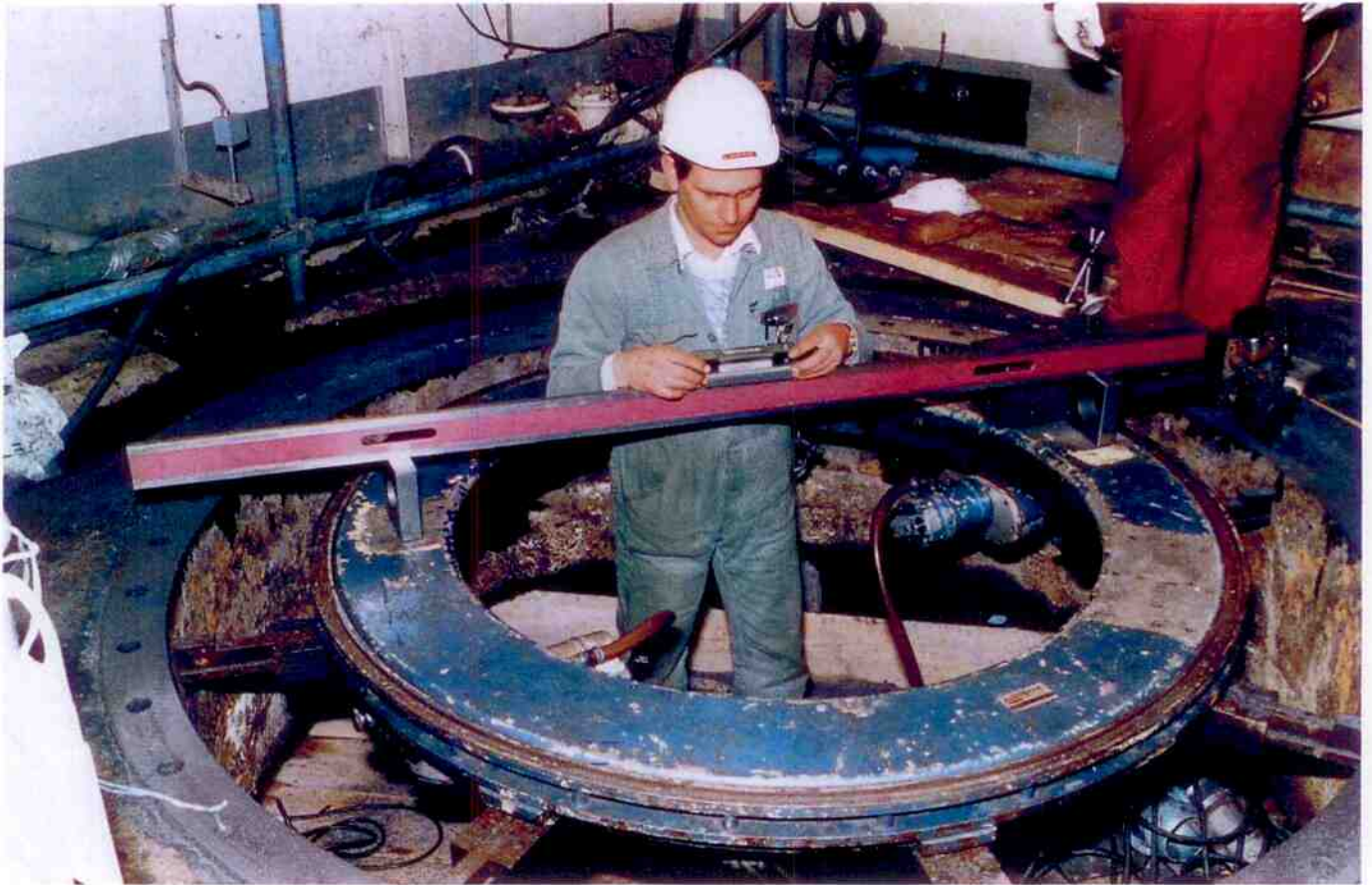
Een kottermachine wordt horizontaal gesteld bij een pompfundering.
